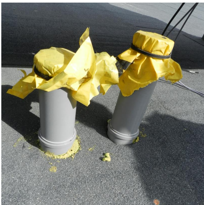
Obr. 6 Chýbajúce opracovanie povlakovej krytiny v detaile prestupu potrubia
