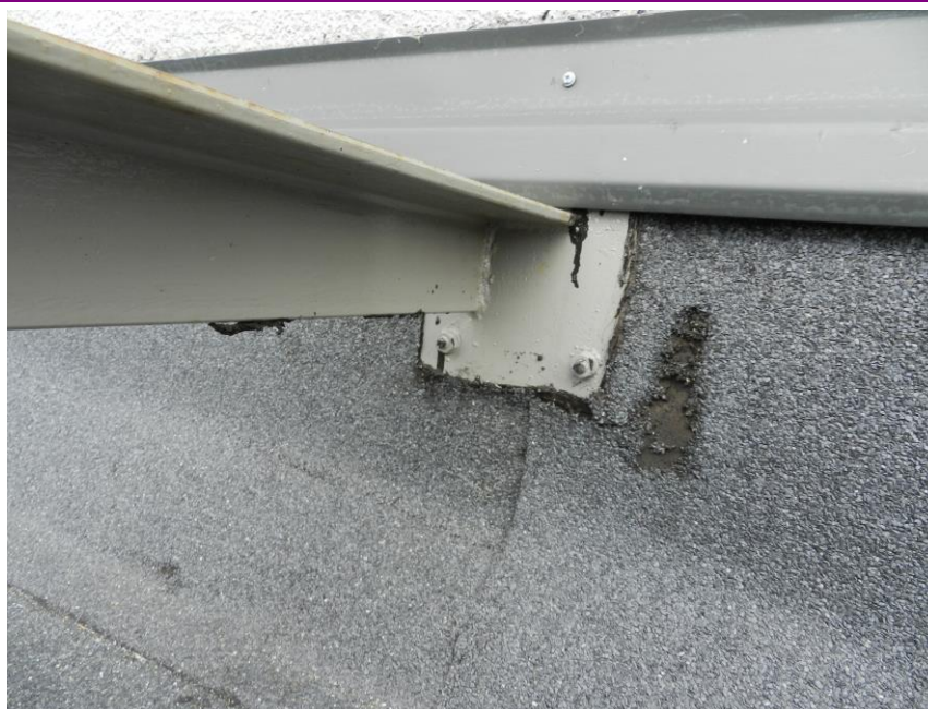
Obr. 3 Kotvenie ocelového profilu v detaile styku pri vysokej stene
