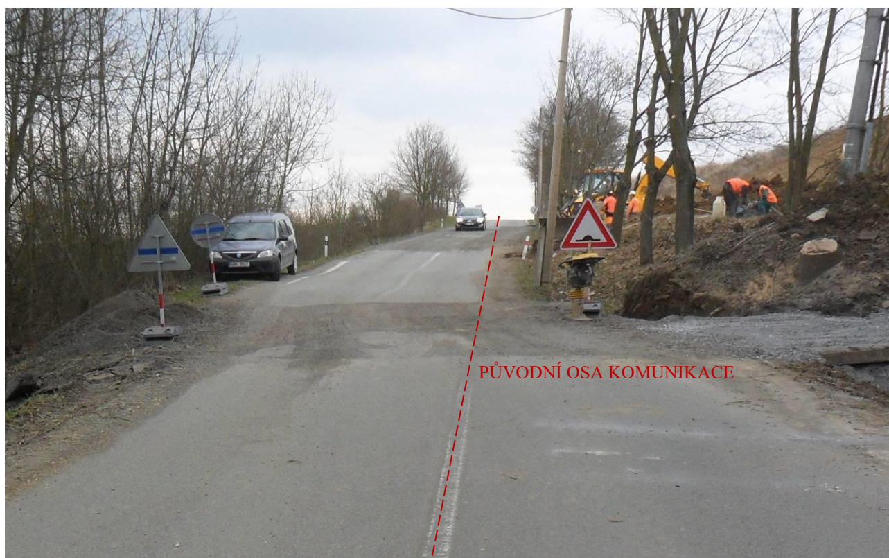
Obr. 4 Posun části komunikace o jednotky metrů
