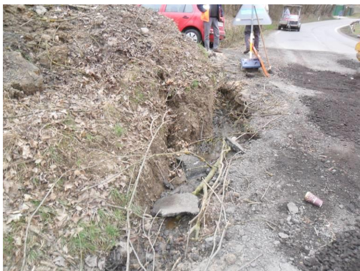
Obr. 7 Nefunkční (zanesený odvodňovací příkop)
