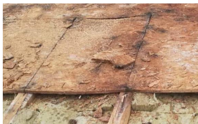
Obr. 11 Strecha obdobnej konštrukcie 8 rokov od realizácie (foto M. Kováč)
