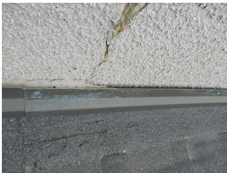
Obr. 1 Absencia krycej lišty – detail styku pri vysokej stene
