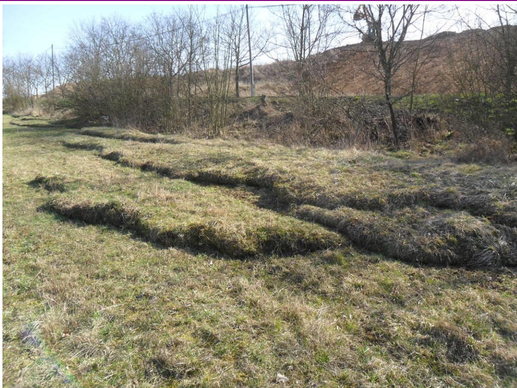
Obr. 3 Deformace zeminy pod komunikací
