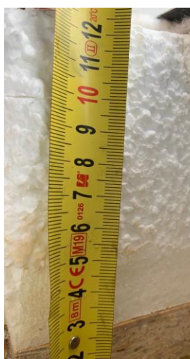
Obr. 3 Pohľad na hrúbku EPS (100 mm) vo vykonanej sonde
