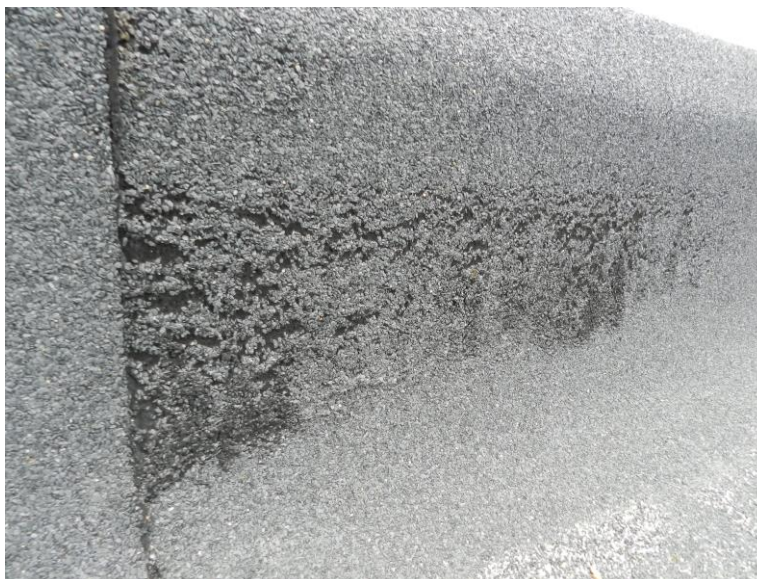
Obr. 7 Nesprávne osadenie asfaltovaného pásu v detaile atiky
