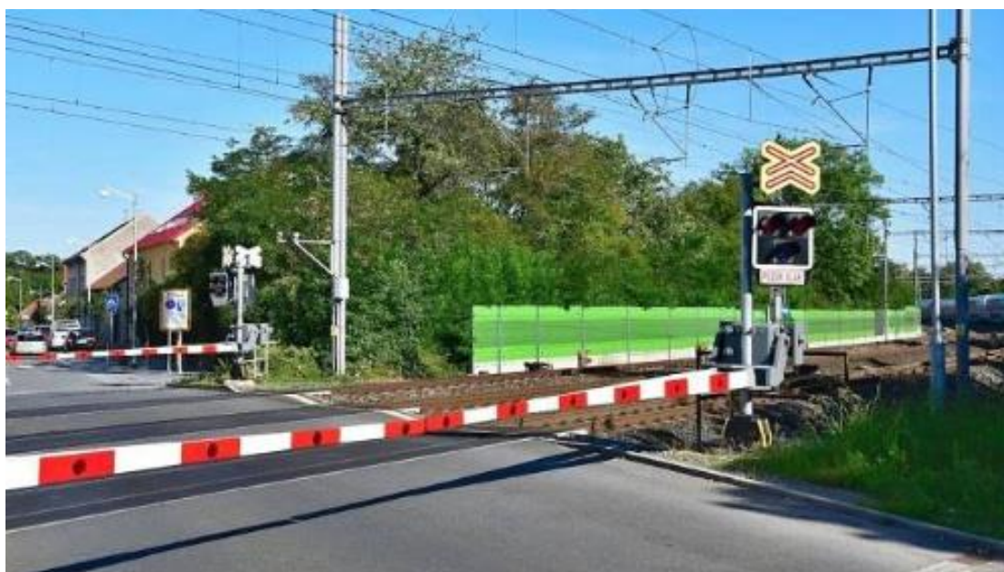
Obr. 19 Železniční přejezd se světelnou signalizací na vícekolejně trati doplněný celými závory (přejezd uzavřen)
