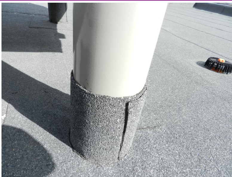
Obr. 5 Nesprávne opracovanie povlakovej krytiny v detaile prestupu potrubia
