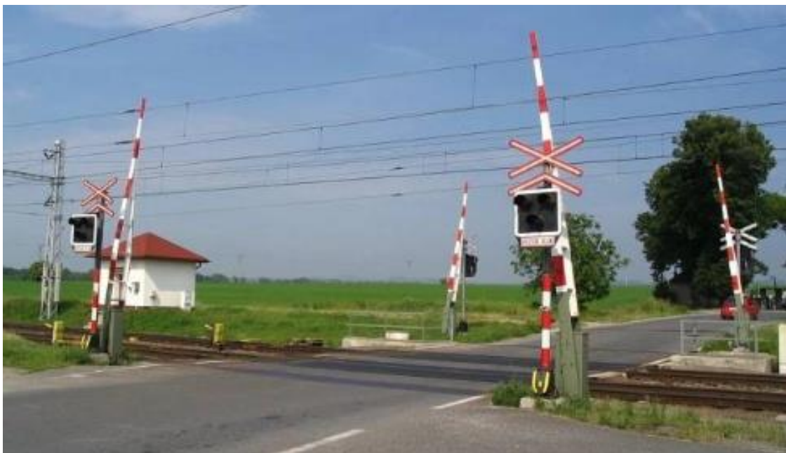
Obr. 18 Železniční přejezd se světelnou signalizací na dvojkolejně trati doplněný celými závory (přejezd otevřen)
