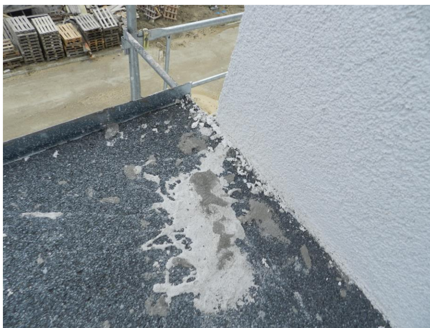
Obr. 4 Ukončenie povlakovej krytiny v detaile styku pri vysokej stene
