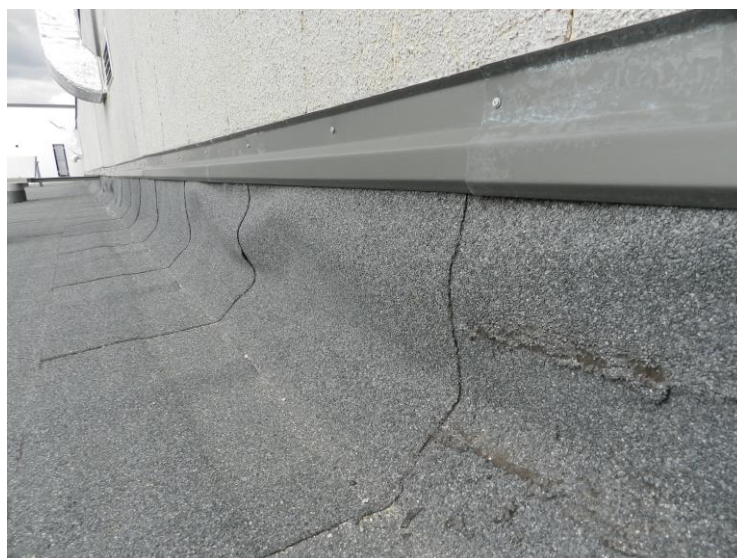
Obr. 2 Zvlnenie povlakovej krytiny v detaile styku pri vysokej stene
