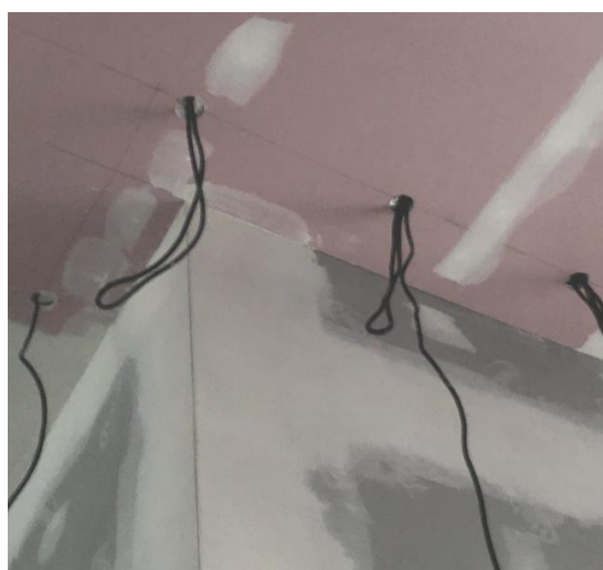
Obr. 4 Perforácie parozábrany (neupravené - neprelepené)
