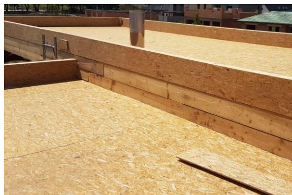
Obr. 2 Pohľad na základ z OSB dosiek posudzovanej strechy
