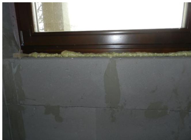
Obr. 12 Absencia paronepriepustnej úpravy
