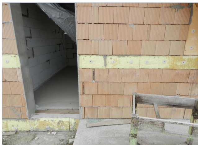
Obr. 13 Prerušenie obvodového венca
