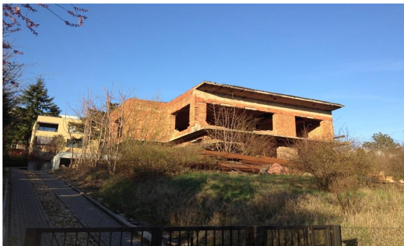
Obr. 22 Dlouhá léta rozestavěná a zchátralá stavba na ulici Preslova
