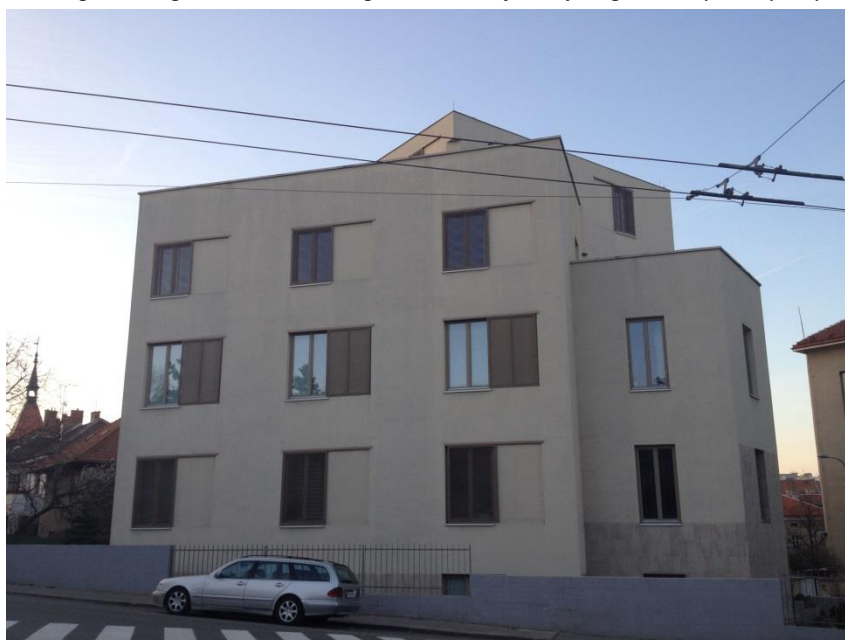
Obr. 7 Výsledná podoba bytového domu na ulici Všetickova 1
