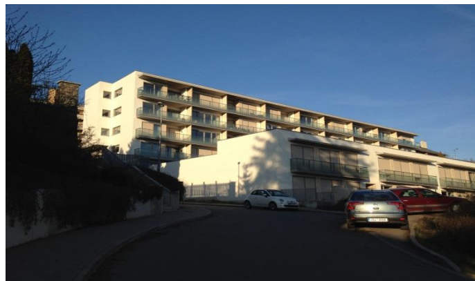
Obr. 4 Rezidence Martinů – pohled z ulice Preslova
