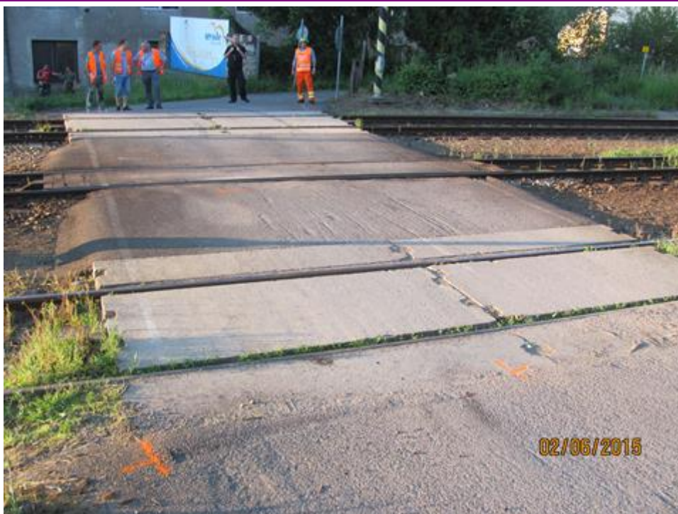
Obr. 11 Dopravní plocha železničního přejezdu
