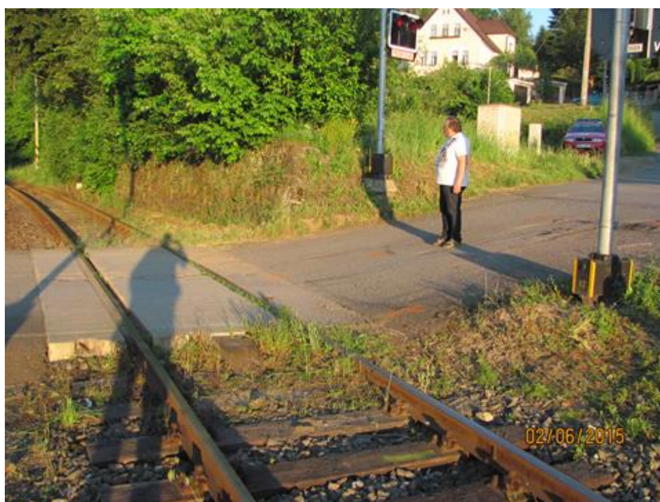
Obr. 12 Dopravní plocha železničního přejezdu s navazující vozovkou
