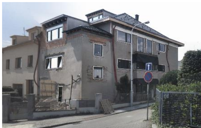
Obr. 11 Přestavba bytového domu [1]
