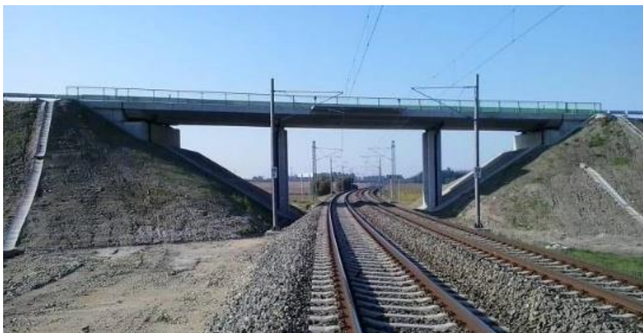
Obr. 1 Nadjez nad železniční tratí
