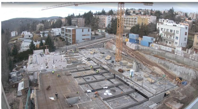
Obr. 23 Probíhající výstavba bytového komplexu Neumanka
