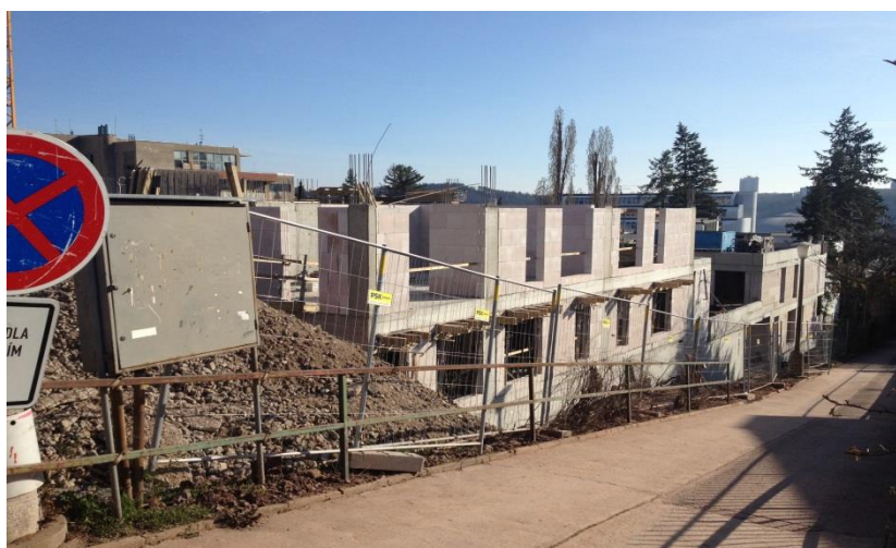
Obr. 24 Probíhající výstavba bytového komplexu Neumanka, stav k 29.3. 2019
