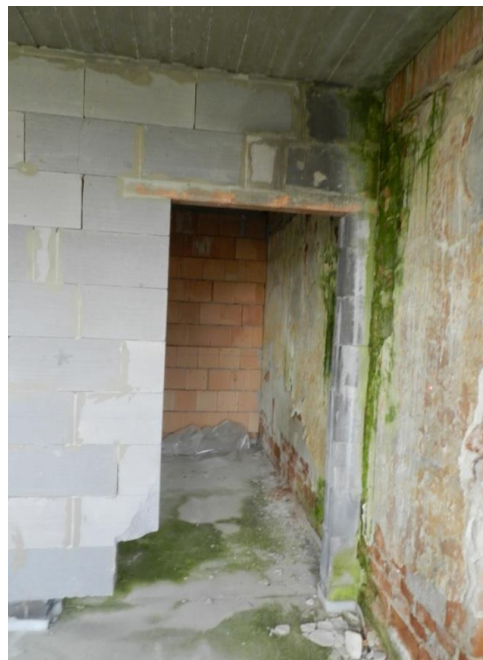
Obr. 8 Prejav zatekania z otvorenej terasy
