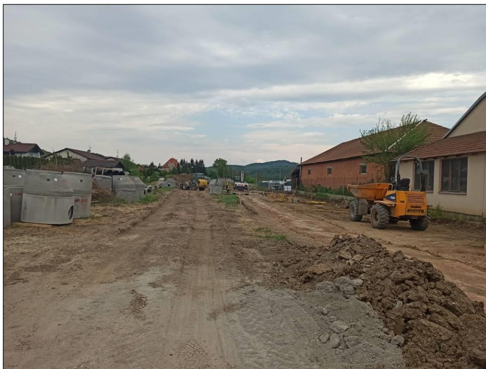
Obr. 8 Probíhající výstavba komunikace a inženýrských sítí – ulice Milonická
