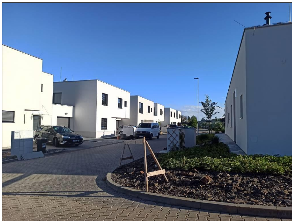
Obr. 10 Část ulice Na Rybízárně, nová zástavba rodinných domů
