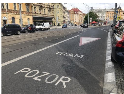
Obr. 9 Nápis POZOR TRAM v ulici Milady Horákové, zdroj: auto.tn.nova.cz
