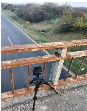
Obr. 6 Stanice videokamery nad místem měření [autor]
