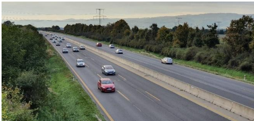
Obr. 8 Příjezd kolony vozidel k místu měření [autor]
