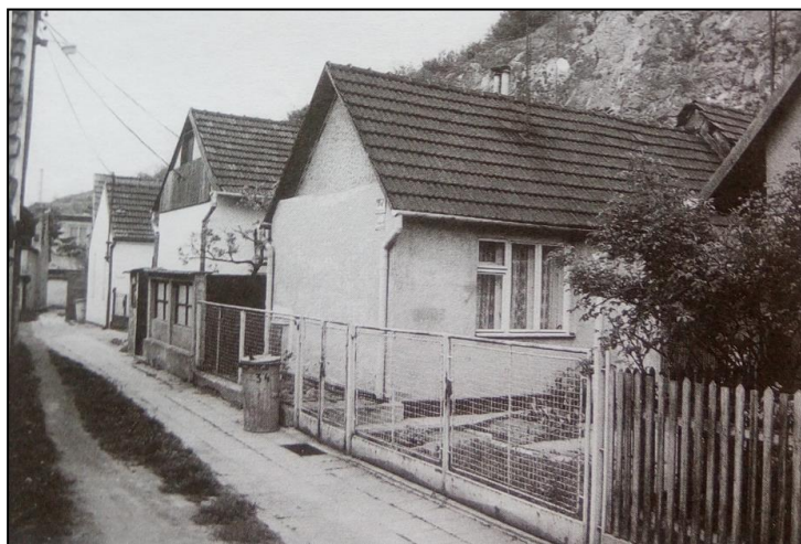
Obr. 8 Kolonie v Resselově ulici v Králově Poli, foto z roku 1988 [8]
